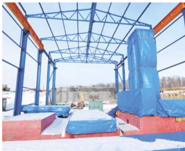
Часть оборудования уже смонтирована в будущем цехе.
