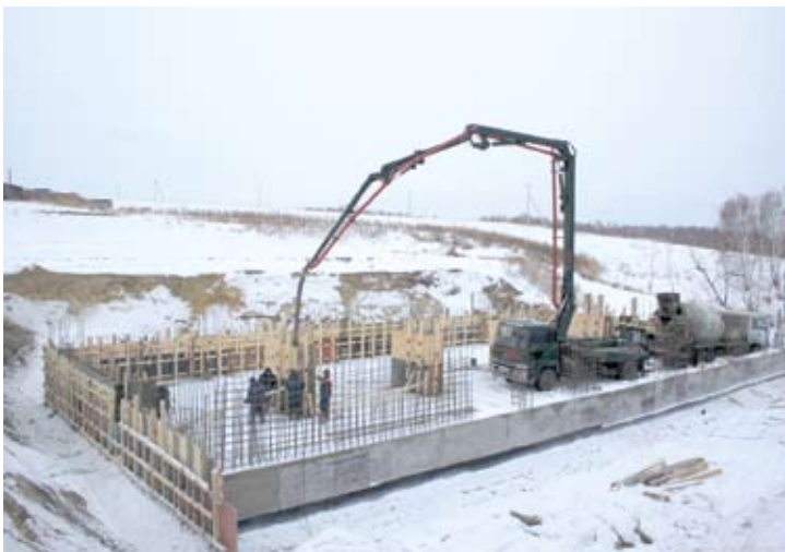
Под станки-гиганты нужен многометровый фундамент.
