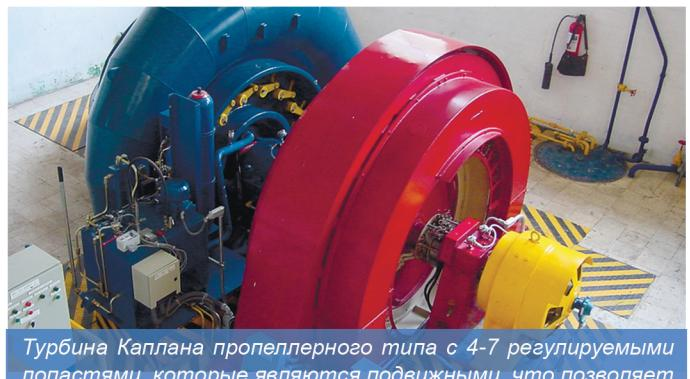
Турбина Каплана пропеллерного типа с 4-7 регулируемыми лопастями, которые являются подвижными, что позволяет регулировать расход воды и мощность турбины
