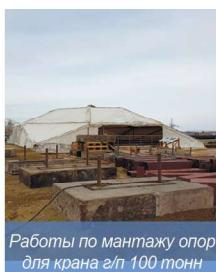
Работы по монтажу опор для крана г/п 100 тонн
